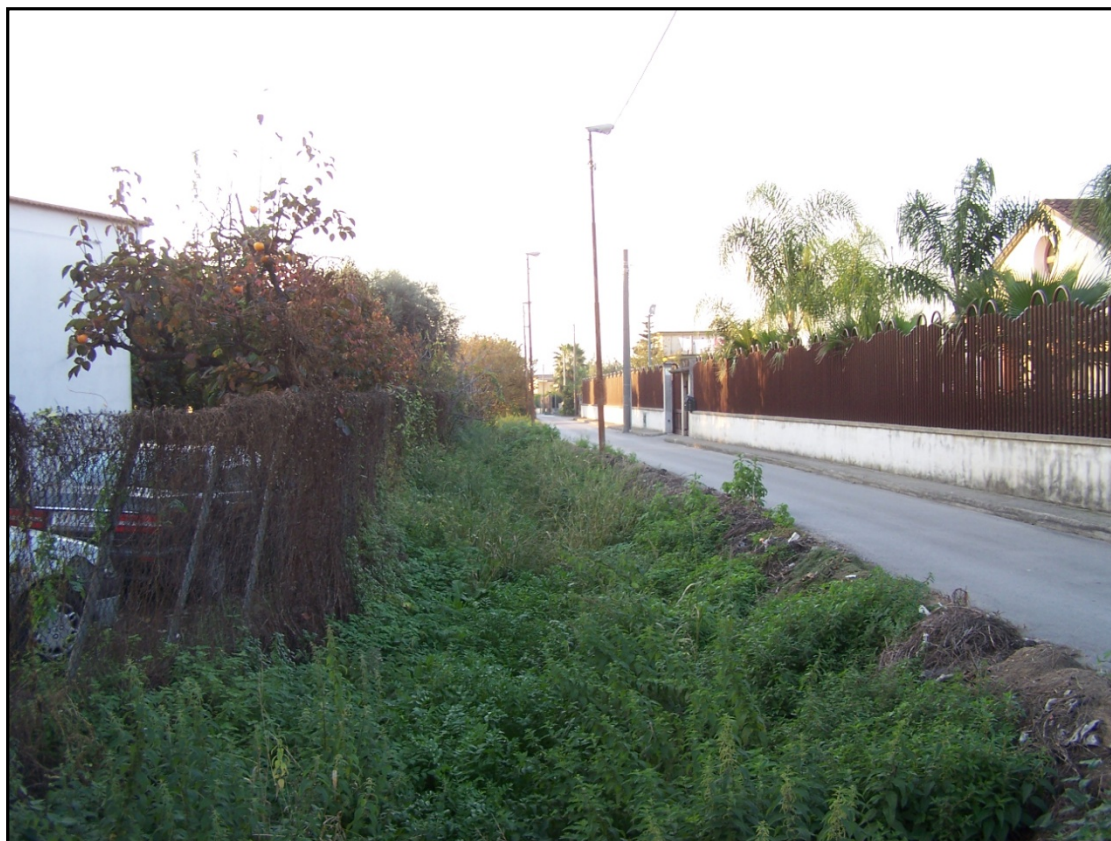
Foto 9. Le condizioni di alcuni canali rilevati sul territorio comunale di San Marzano sul Sarno.
